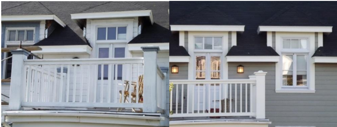
Figure 40. Exemple d'intervention réussie : avant et après la rénovation de fenêtres du 165, chemin de l'Anse-des-Mercier, Ruralys , 2013
