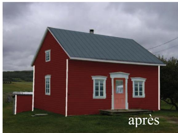
b) Agrandissement des fenêtres et utilisation de fenêtres à 6 carreaux avec ajout d'encadrements et d'un décor de porte. Nouveau revêtement des murs avec planches cornières. Nouvelle toiture de tôle imitant la tôle pincée.
